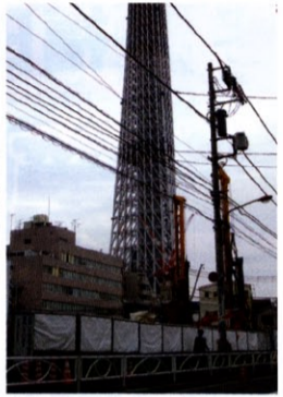
解体工事中の業平橋ポンプ所
